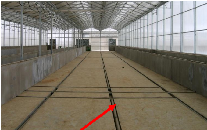
لوله های سیستم هوادهی از کف سالن
